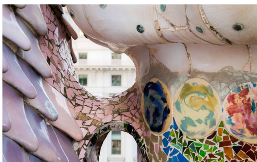
Dach der Casa Batlló
